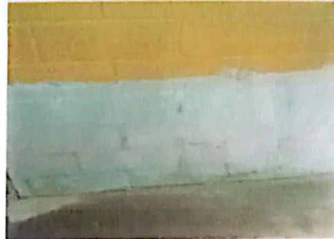
Foto 2: Colocación de azulejo
