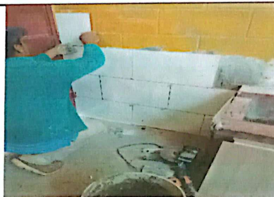
Foto 4: Colocación de azulejo
