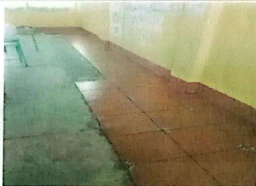
Foto 6: Cambio y colocación de piso en aulas
