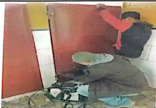
Foto 3: Cambio y colocación de puertas
